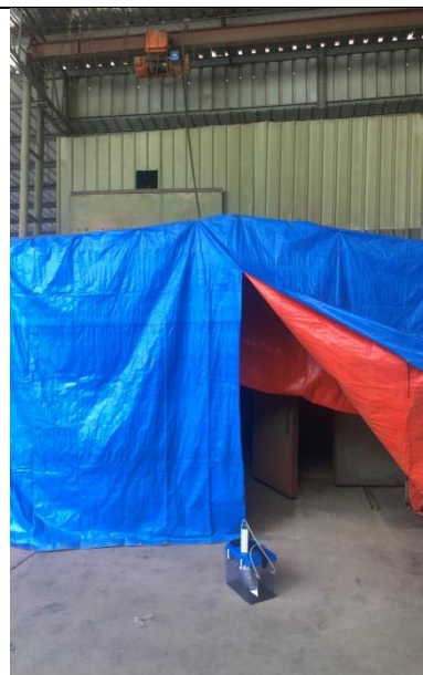
烘干线2#生产车间出入口5#
